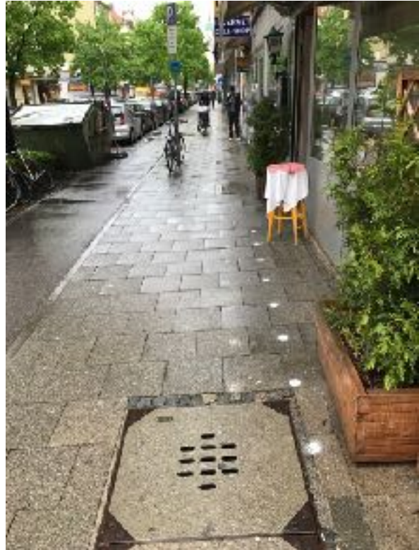
Ansicht Augustenstr. mit bestehender Reduzierung jeweils Alte und Neue Punkte sichtbar
